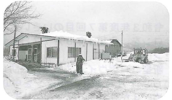
屋根の雪下ろし作業の様子
