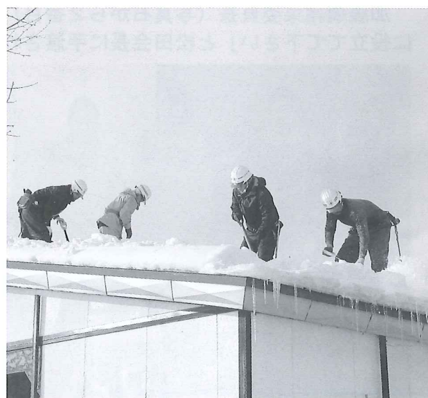
(株)山越組による屋根の雪下ろし作業の様子
