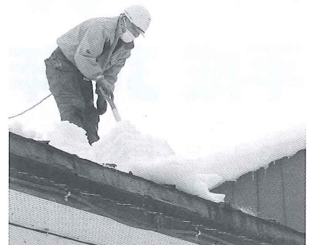
雪下ろし作業の様子
