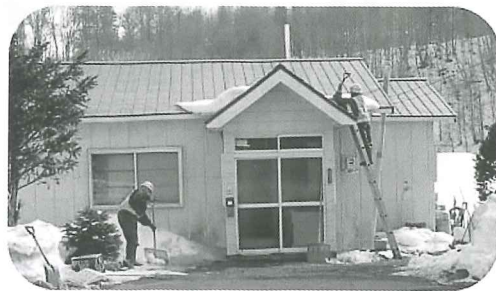
屋根の雪下ろし作業の様子
