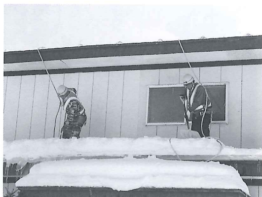
危険な屋根の雪下ろし作業を 5名の山越組の方がしてくれました
